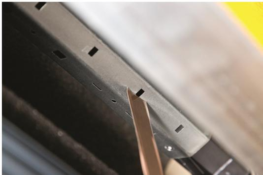
Die Nase der Aufhängefeder diagonal in die Rechteck-Ausstanzung der Welle einführen und zum sichern eindrehen.
