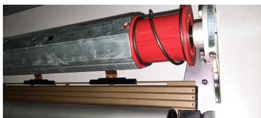
Zur Einstellung der unteren Endlage den Behang komplett abfahren, bis alle Lamellen komplett geschlossen sind. Lotgerechte Auflauffläche prüfen und sauberes Behangbild herstellen. Das Herausfahren des Behang aus den Seitenschienen ist zwingend zu vermeiden.
