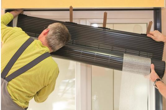
Den Behangwickel vorsichtig entnehmen. Der Behang darf beim Einbau keinesfalls geknickt oder am Boden um- bzw. abgewickelt werden.
